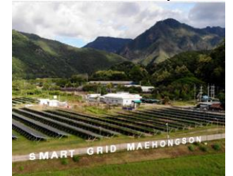
Mae Hong Son Smart Grid Project
